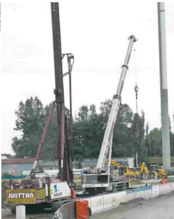
780 pali pod trybunę muszą wbić budowlancy. Gdyby je ułożyć jeden za drugim, ciągnęłyby się na długość 11 kilometrów
